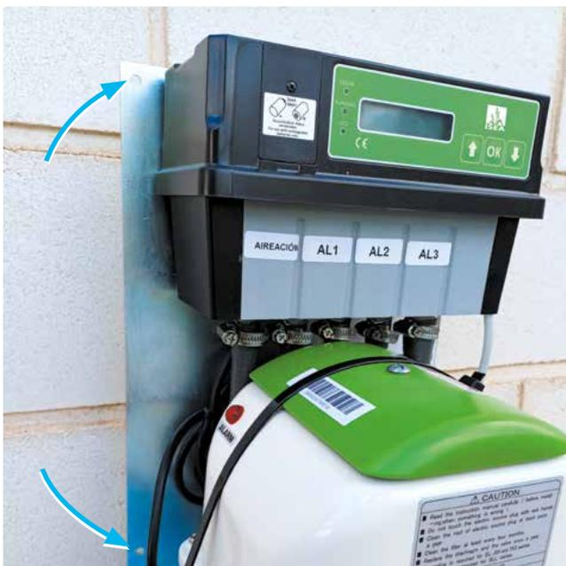
Montaje del unidad de control con soporte de chapa de acero.
